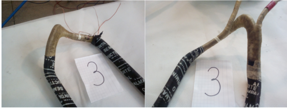
Figura 4.31: Inspección visual de Bobina 3
