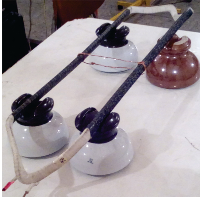
Figura 6.2: Montaje de bobina unión de conductor central
