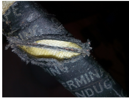
Figura 6.23: Emulación de fractura de aislamiento principal de bobina.
