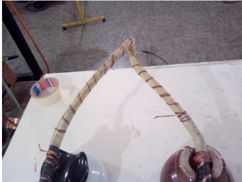
Figura 6.14: Emulación de contaminación superficial grading .
