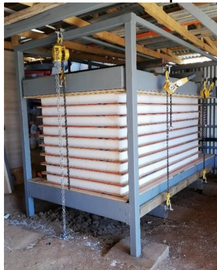
Figura 5.3.3.3. Prensado de nueve paneles de 114 [mm]
