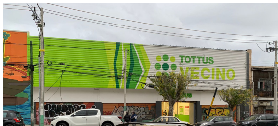
Imagen 4, Fachada actual Tottus. Fuente: Elaboración propia.
