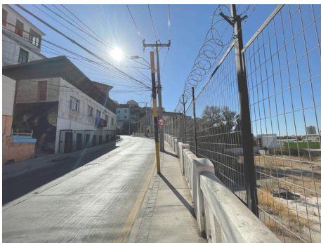
1) Imagen sitio Calle Baquedano
