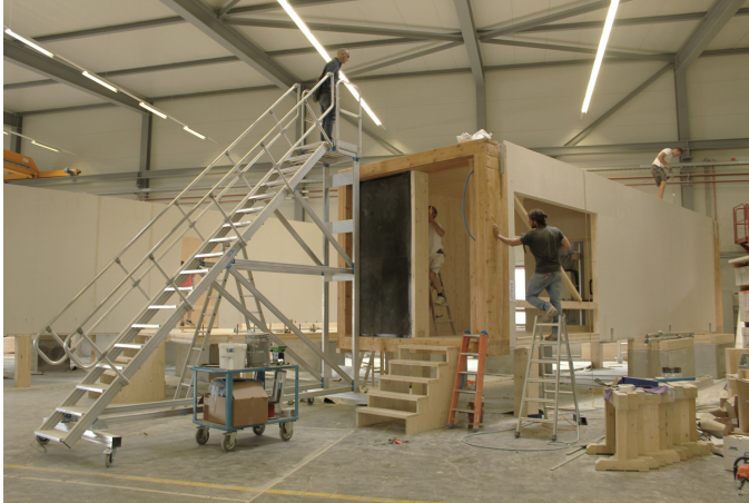
Figura 65. Proceso de fabricación, transporte y montaje.
