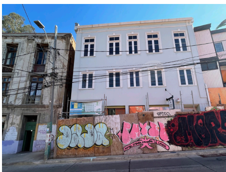
2) Imagen sitio Renovación ascensor
