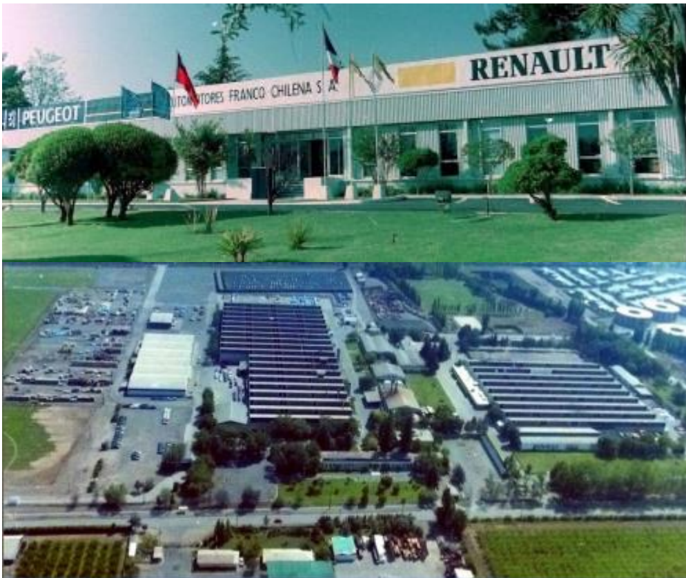
Figura 15: Instalaciones AUTOMOTORES FRANCO-CHILENA
