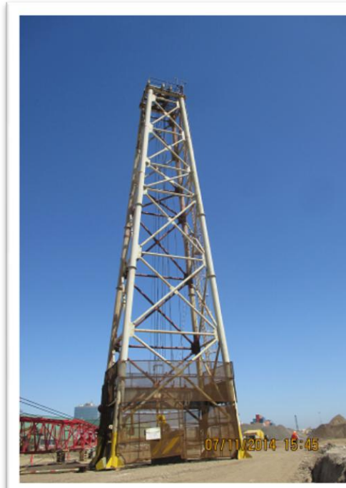
Imagen 1: Torre de compactación, 30 metros de altura, desde la cual se eleva el dado de hormigón a 25 y 20 metros de altura para dejarlo caer.
