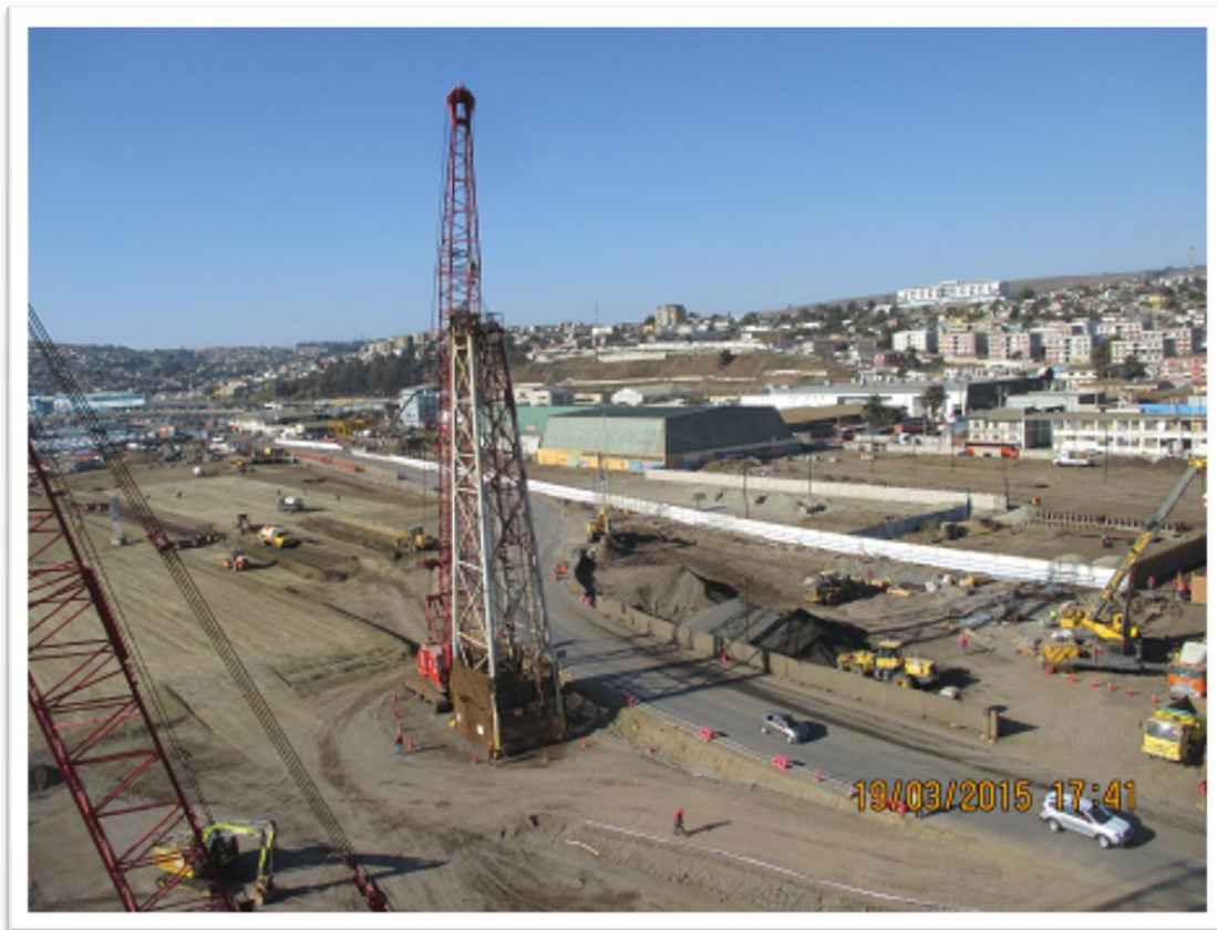
Imagen 3: Elevación del dado de compactación, a altura de 20 metros, para realizar golpeo de cancha
