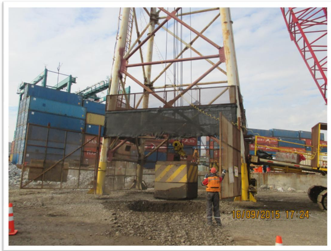
Imagen 6: Cavidad dejada por el dado después de una fase de impacto. Además se puede ver en la foto la reja de proyección de partículas que posee la torre.
