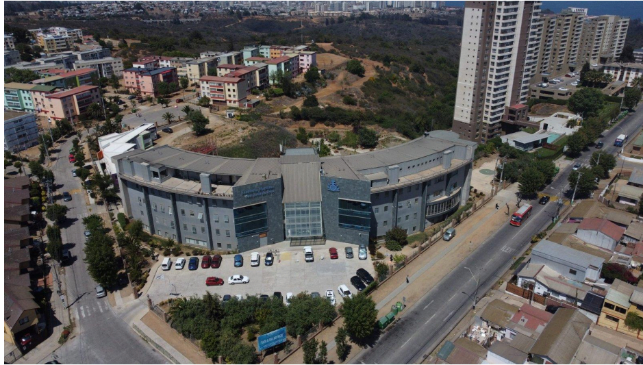
Figura 1-2. Sanatorio Marítimo San Juan de Dios vista aérea
