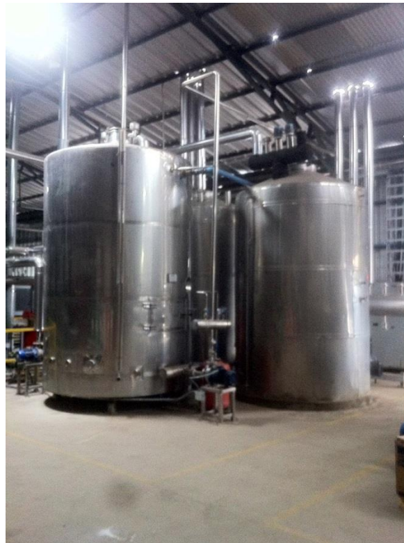
Figura 11: Cubas de frio sin aislar
