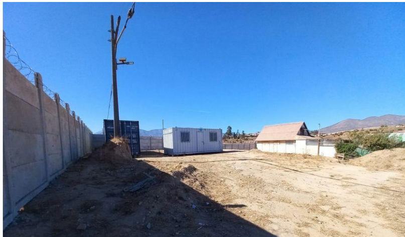
Figura 1-1. Vista frontal instalaciones Andrés bello 769
