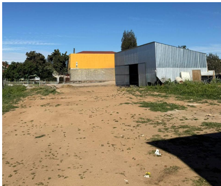
Figura 1-2. Vista frontal instalaciones Calle 12 de febrero 285
