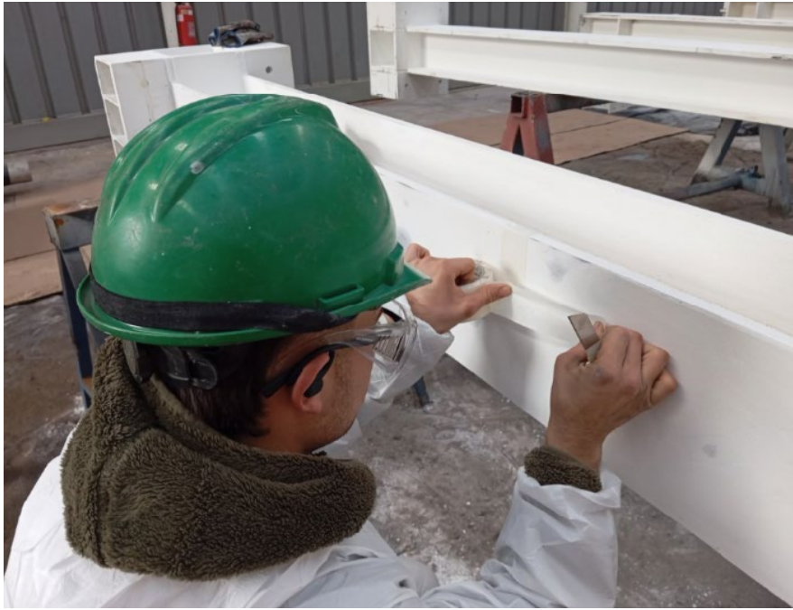
Figura A-22. Aplicación de touch up.
