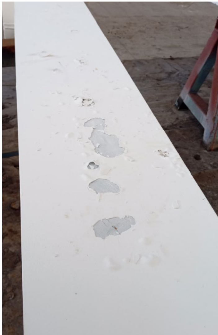
Figura A-23. Error de aplicación.
