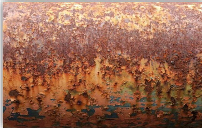
Figura 2-8: Corrosión Externa en Tubería.
