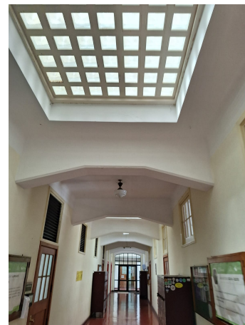
Figura 3.7. Marco de hormigón en el techo que introduce discontinuidades en el Tramo LoS.
