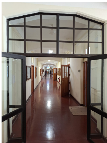
Figura 3.6. Marco estructural de metal y vidrio en el Tramo LoS, cerca del punto de quiebre.
