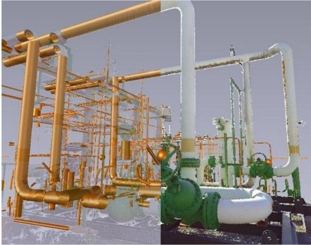
Ilustración 2-10 Proyecto realizado mediante nube de puntos Fuente: (MINICONSTRUCCIONES, 2019)
