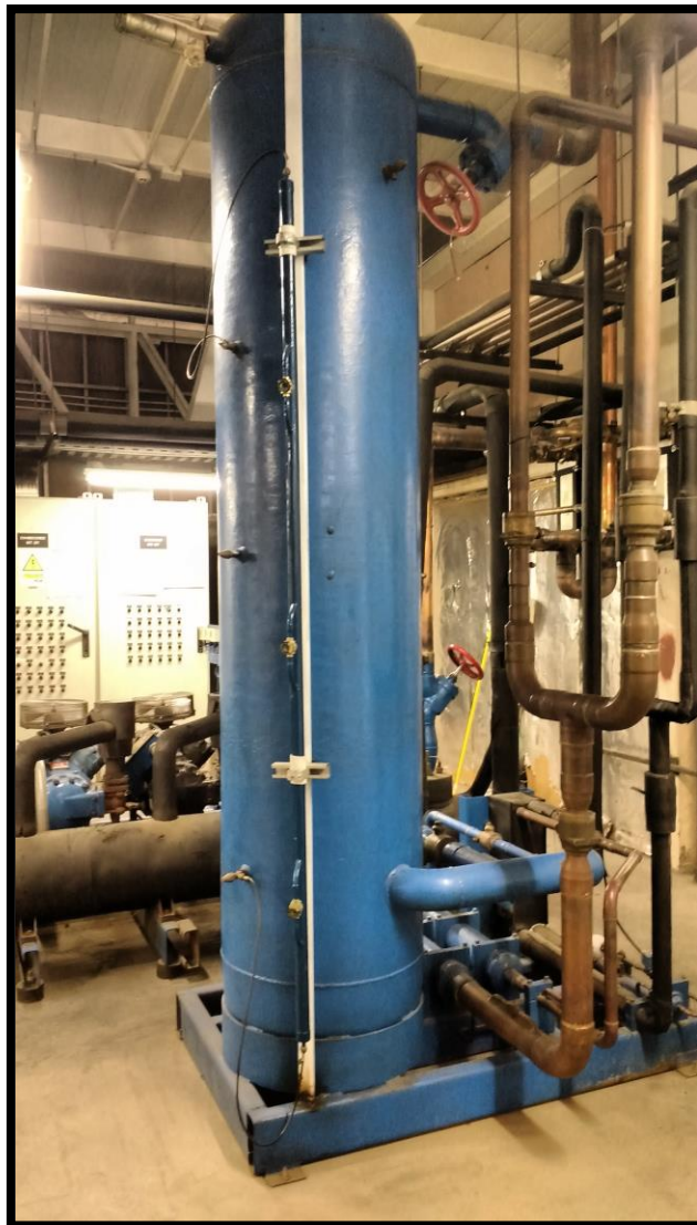
Figura 2.10 Sistema de control de nivel de refrigerante.
