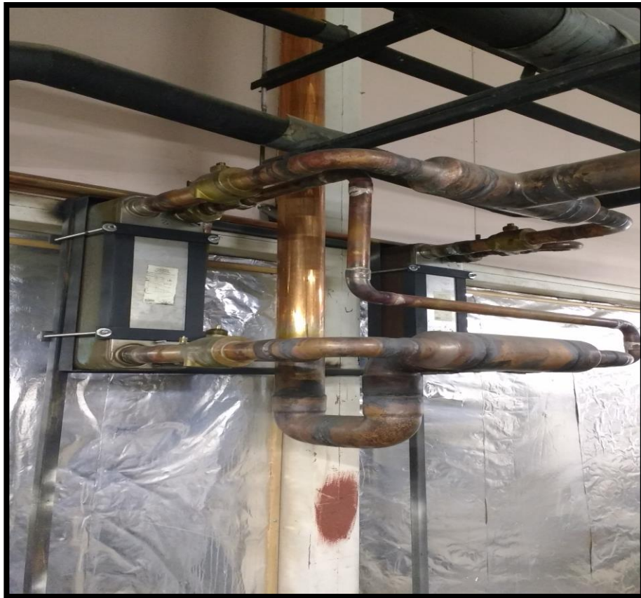
Figura 2.9 Intercambiador de calor tipo placa.
