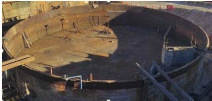
Figura 13: Tk 800 en reparaciones (actualmente está reparado).
