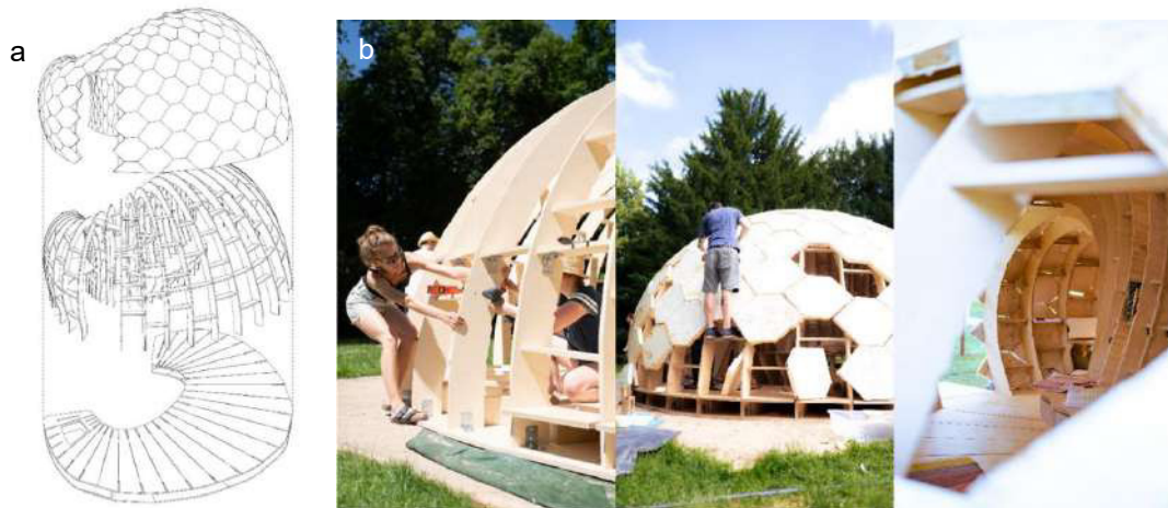
Figura 4.13 Pabellón MY-CO SPACE: estructura y ensamblaje.
