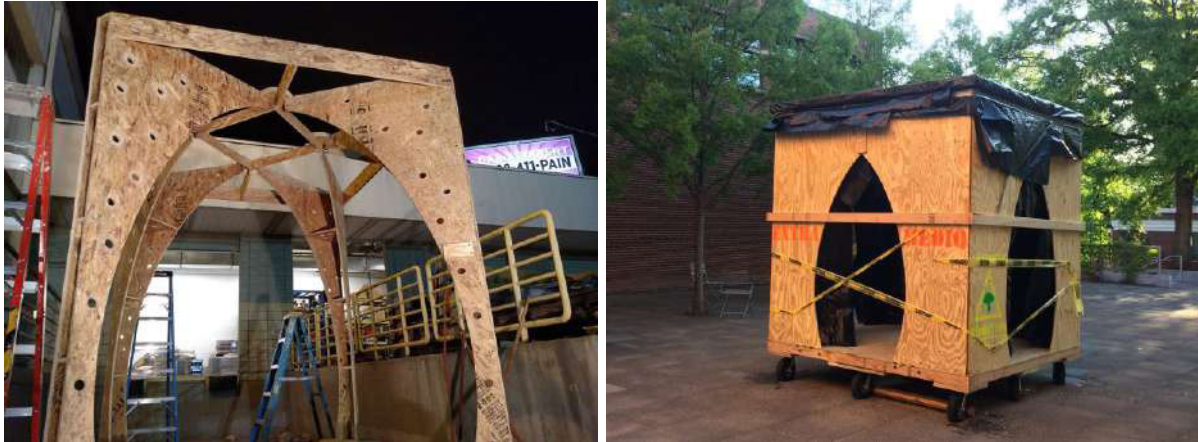
Figura 4.8 Esqueleto de refuerzo interno (izquierda) y Montaje in situ (derecha) de Monolito Micelio.
