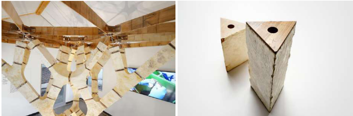
Figura 4.6 Detalle de Unión (izquierda) y Bloque Individual (derecha) de MycoTree.
