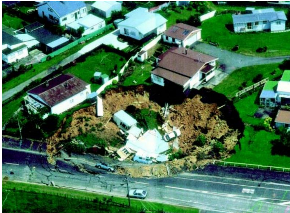
Figura 3.5 Derrumbe de un pilar corona en Waihi, Nueva Zelanda, 2001 ( Carter, 2014 ) .
