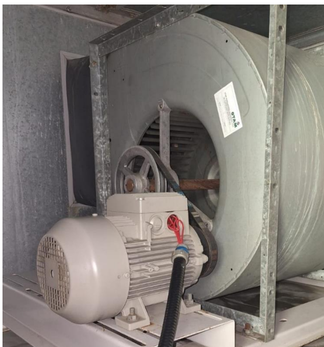
Ilustración 7: Conjunto Motor-Ventilador
