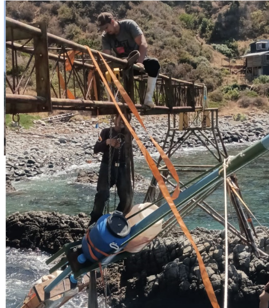
Figura 60: Alzamiento sobre el puente del equipo WSD-IV.
