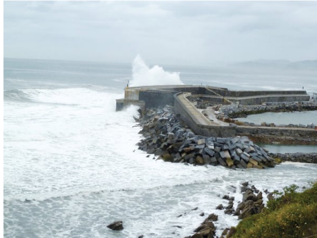
Figura 12: Planta Mutriku e instalación de rompeolas en las costa de Vizcaya, en el país Vasco Español[20]
