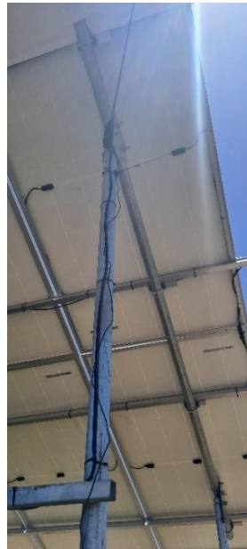
Figura 2-17 Antena en soporte estructura FV
