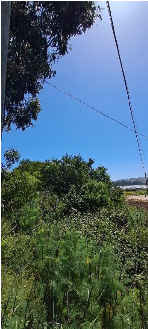
Fuente: Foto real proyecto fotovoltaico, Coop. M. Alfonso, Longotoma
