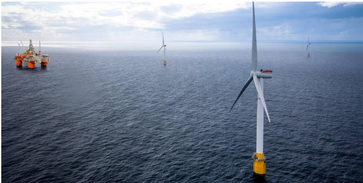
Figura 3.2: Turbina flotante de tecnología Spar del Hywind Tampen Project
