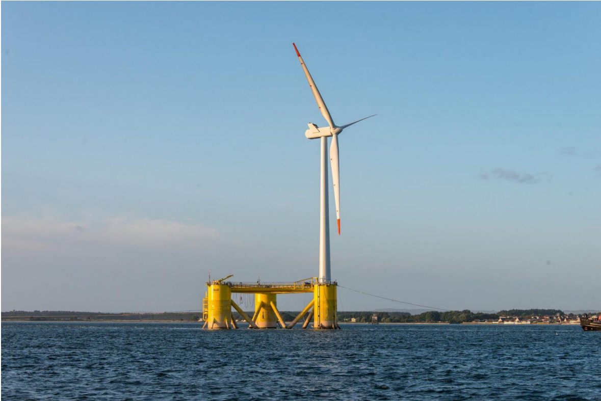
Figura 3.3: Turbina flotante de tecnología semi-sumergible del Kincardine Offshore WindFarm
