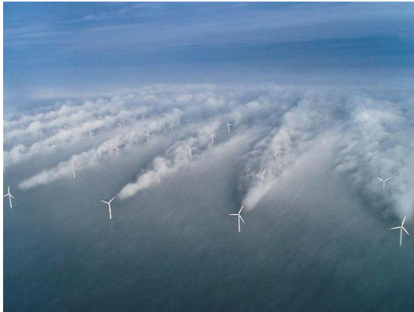
Figura 4.6: Efecto estela en parque eólico Horns Rev (mar del norte)
