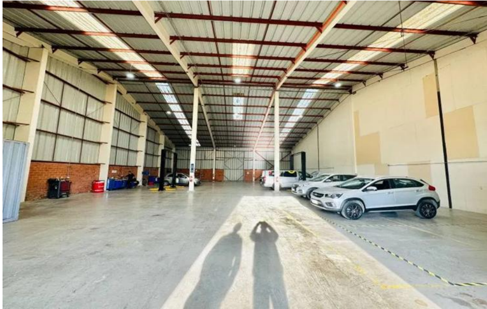
Figura 1-5. Interior del galpón.
