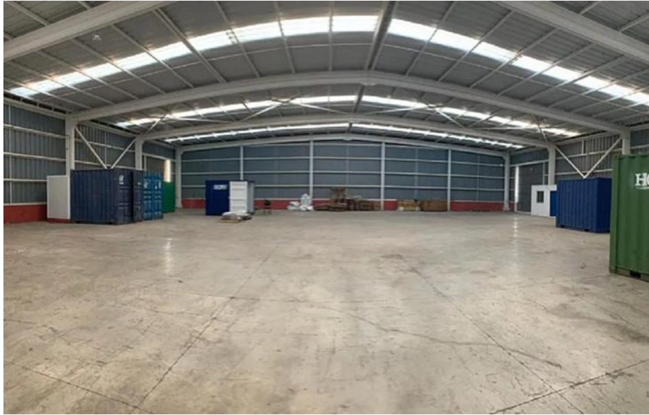
Figura 1-2. Interior del galpón.
