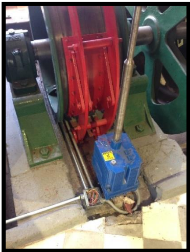
Figura 2.15: Motor de Frenado junto a tambor medial Fuente: Elaboración Propia
