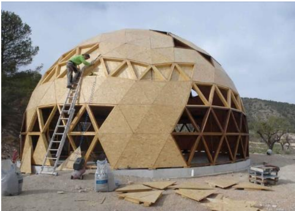
Ilustración 72: Domo en construcción con superficie de radier aislado (Ingedomos.Chile, s.f.)
