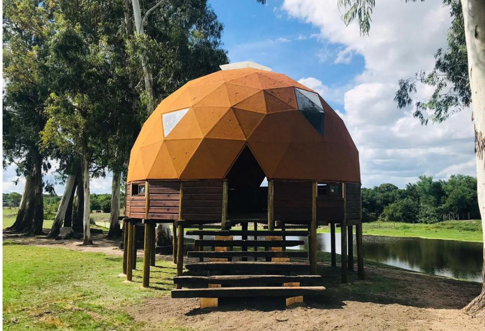
Ilustración 68: Domo Geodésico con revestimiento de Corcho proyectado (Isolcork, s.f.)
