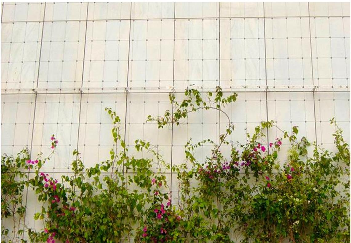
Figura 12. Cables del Sistema Jakob INOX LINE
