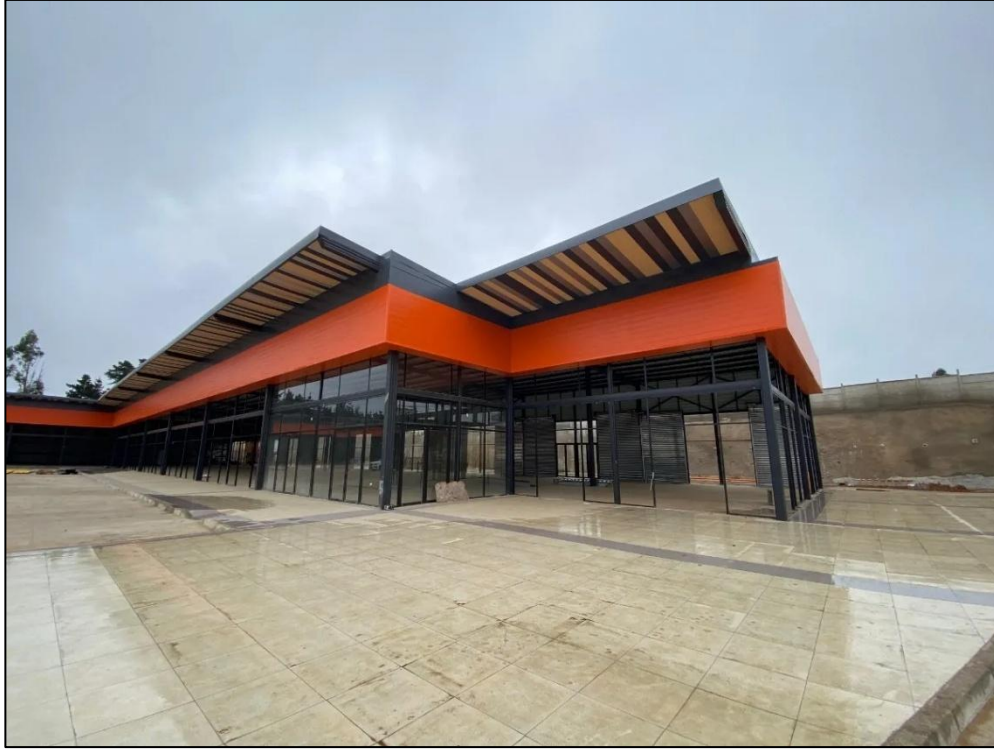
Figura 3-3 Bodega - Terminal de Taxis Colectivos
