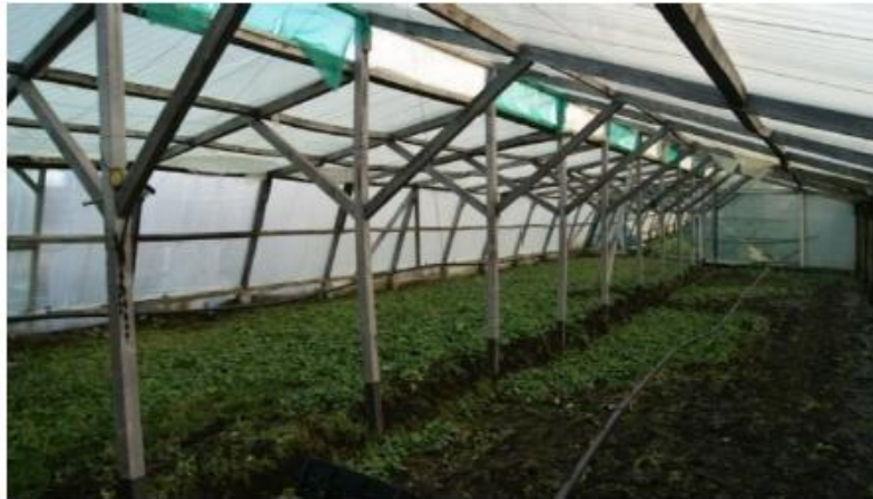
Fig. 2.4. Interior de un invernadero Quillotano; en la parte superior es posible notar la lucarna.
