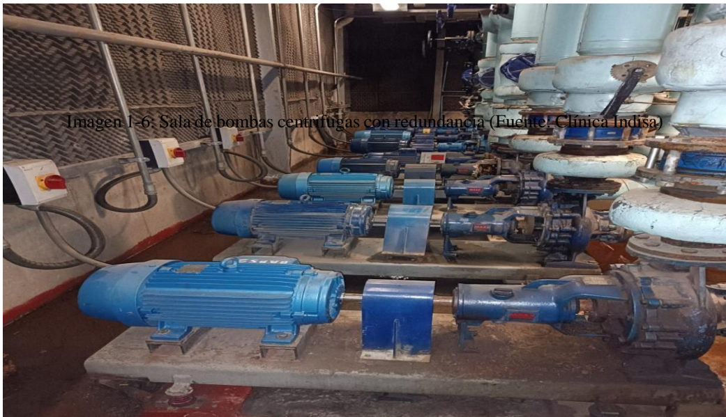
Imagen 1-6: Sala de bombas centrífugas con redundancia (Fuente: Clínica Indisa)
