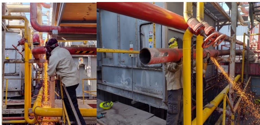
Figura 56: Mejora de tramos de cañerías de NH 3 (Fuente: Elaboración propia, 2021).
