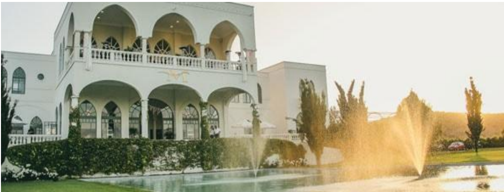
Figura 1-3 Fachada Viña Mar
