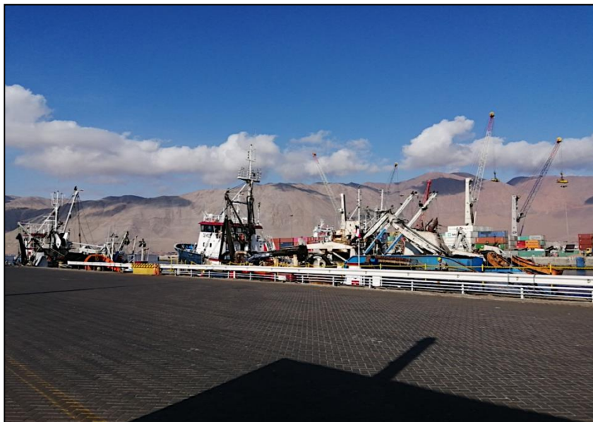
Figura 2-7. Puerto de Iquique, explanada donde se instaló la grúa de izaje
