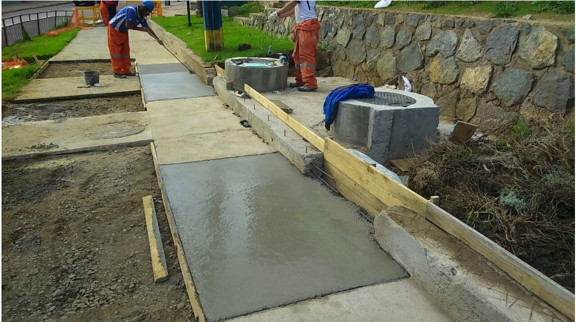
Figura 2.1-3 Reposición Aceras ERP NVA 17, Santa Inés
