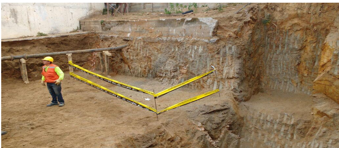
Figura 1.2-4 Inicio obra San Roque
