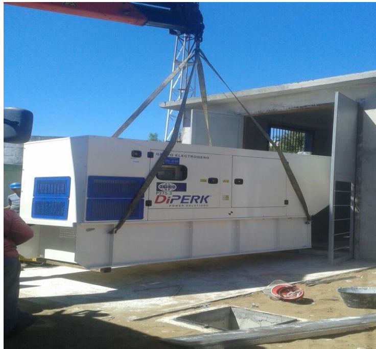
Figura 1.2-3 Instalaci3n generador ConCon Alto
