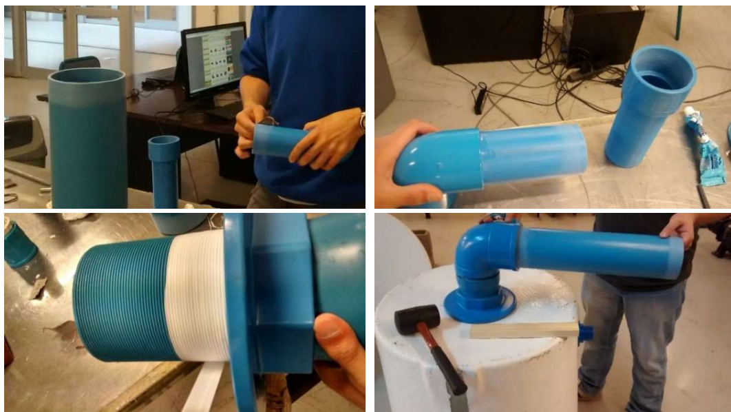
Figura 5.20. Trabajos realizados para construir las conexiones del canal.
