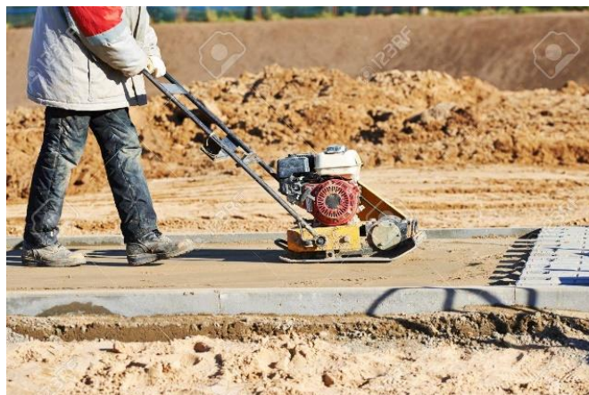
Figura 1.3 Placa compactadora en funcionamiento en terreno
