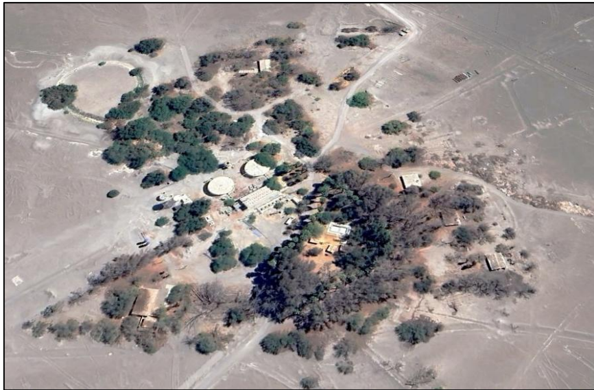
Figura 3-6: Estanques y planta elevadora Canchones. Fuente: GoogleEarth, 2023.
