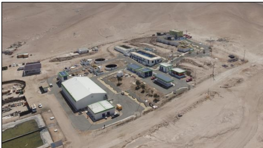
Figura 3-8: Estanques y PTAP Santa Rosa. Fuente: Aguas del Altiplano, 2017.
