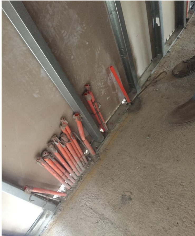
Figura 2-9. Chequeo RTG Instalación Eléctrica
