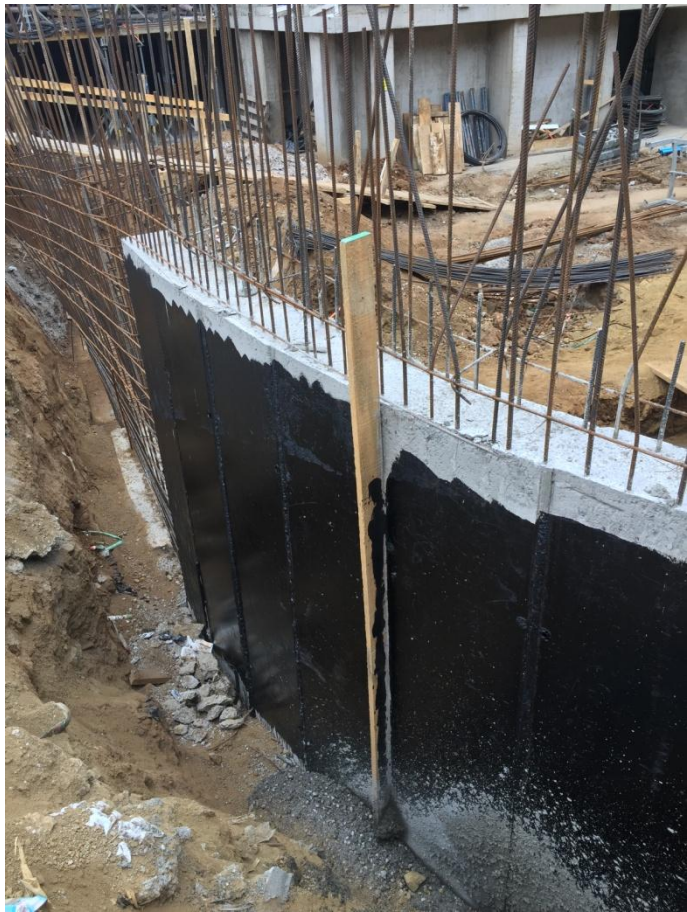
Figura 2-6. Chequeo fierro y pos-tensado losa estacionamiento
