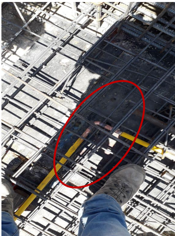
Figura 2-20. Instalación de Gas sin recubrimiento
