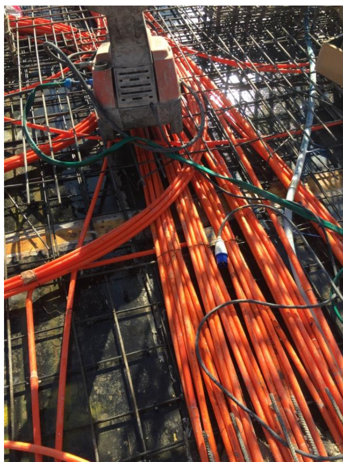
Figura 2-2. Revisión de Instalaciones Eléctricas losa pos-tensada
