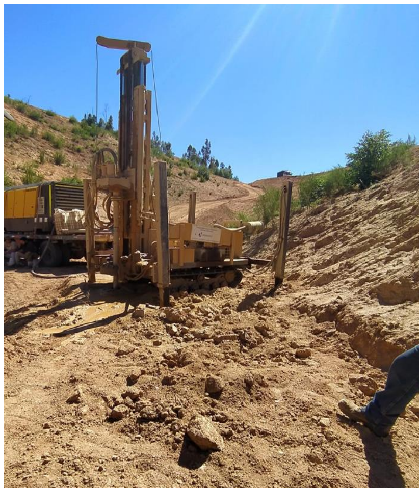
Ilustración 15 perforación pozo fuente: elaboración propia
