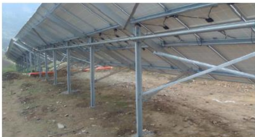
Imagen 6. Cableado módulos fotovoltaicos.
