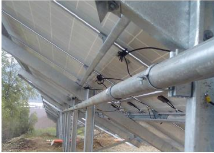
Imagen 8. Canalización en EMT.
