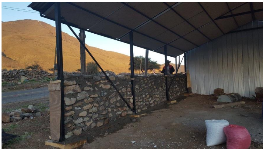
Imagen 1-4. Construcción muro de piedra.
