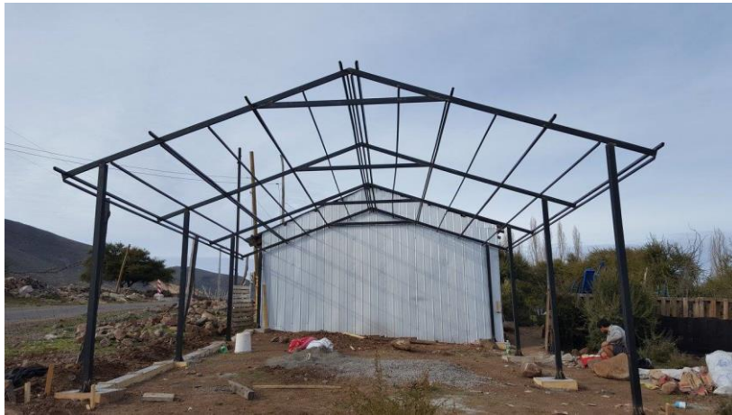
Imagen 1-3. Proceso de construcción de galpón.
