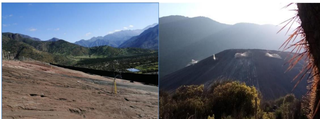
Figura 67: Sistema de aspersores tipo estadio en talud del tranque de relaves N°6 [51].
