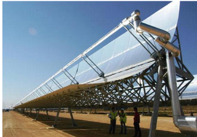
Figura 3-3. Instalación de colector cilindro parabólico [8].
