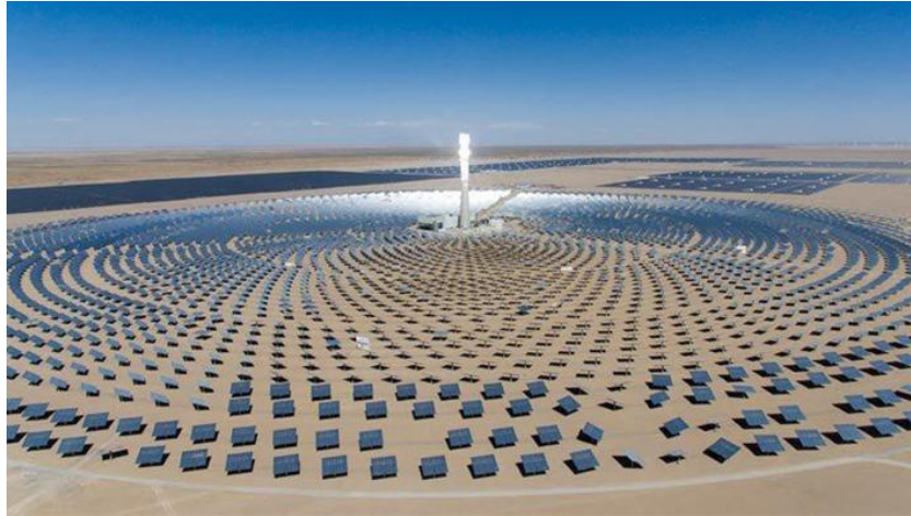
Figura 3-5. Instalación de Planta Termo solar Cerro Dominador, Chile [20].
