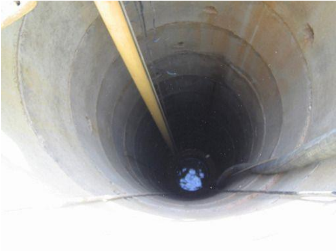
Figura 1-4 Pozo de extracción de agua
