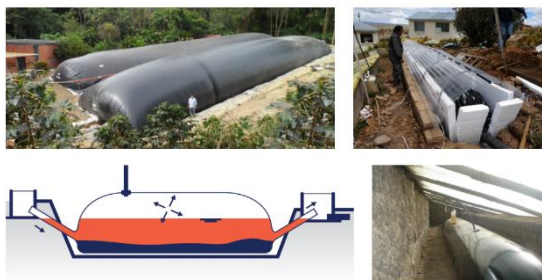
4 Figura 2-3 Ejemplo biodigestor tubular Fuente: Autoconsumo.minenergia.cl
