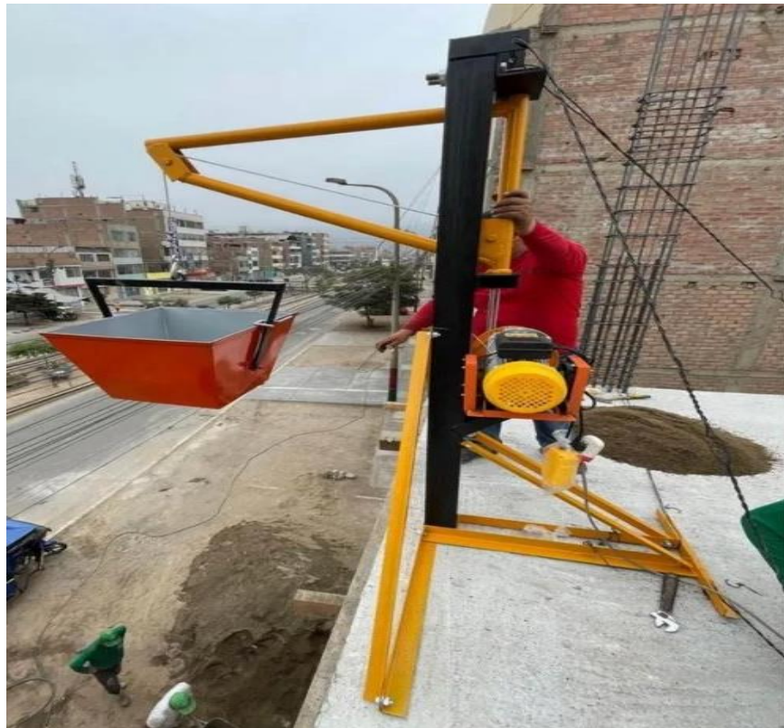
Ilustración 1-19.- Cabrestante en construcción
