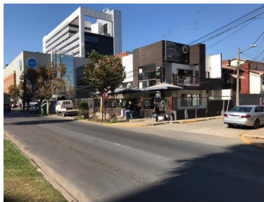
Ilustración 17: Vista exterior del inmueble
