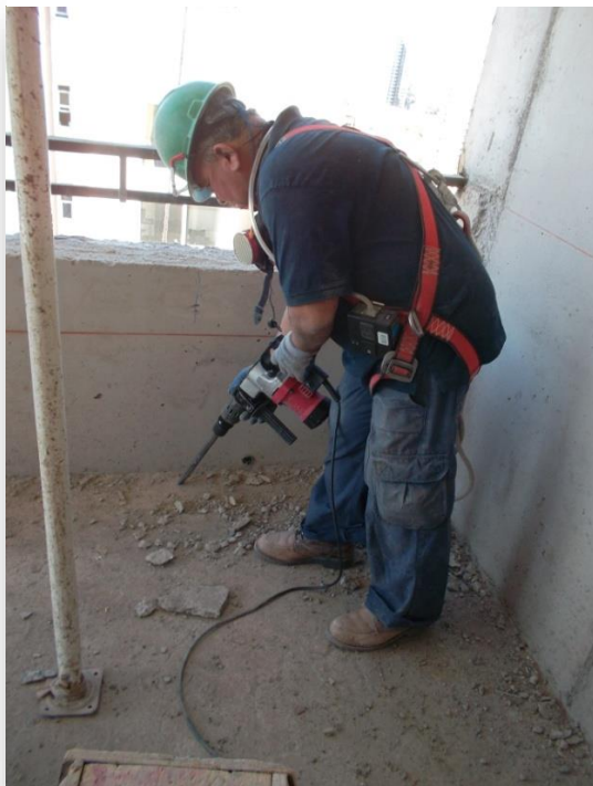
Ilustración 5. Trabajador Utilizando Martillo Neumático.
