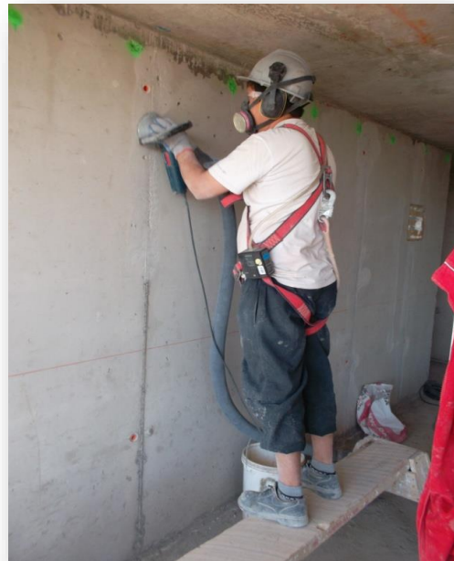
Ilustración 3. Trabajador de la construcción utilizando esmeril angular
