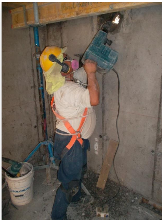
Ilustración 4. Trabajador Utilizando Martillo Neumático.
