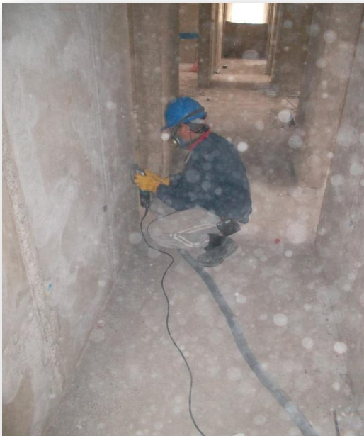
Ilustración 2. Trabajador de la construcción utilizando esmeril angular
