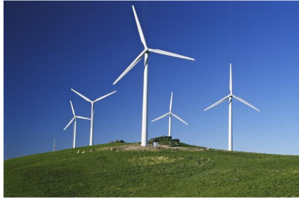
Ilustración 3.3: Aerogenerador de eje horizontal (tripala)
