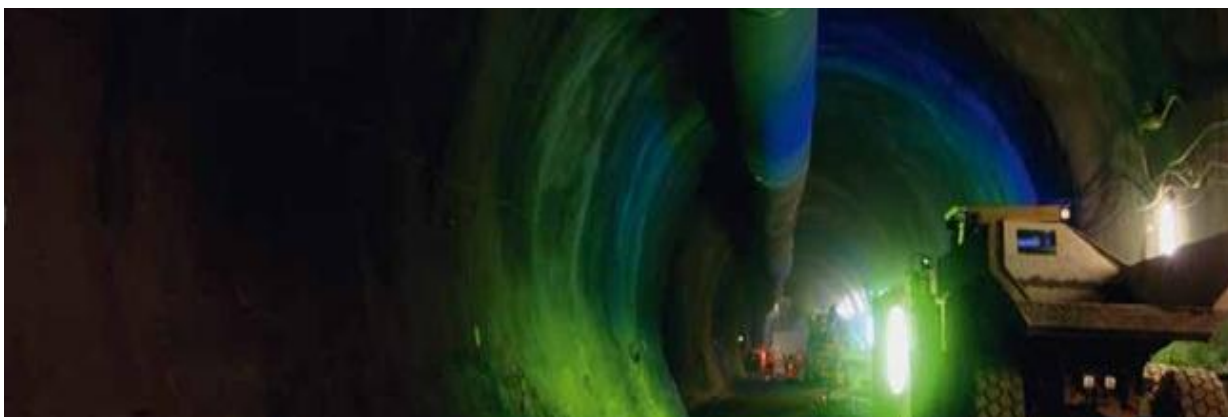
Imagen 2.4). Aplicación HRF por medio de shotcrete en túneles de grandes mineras. (Concrete, SIKA 2010).
