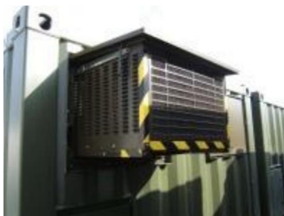
Figura. 4.1 Aire acondicionado AC-M5W para contenedor, con sistema telescópico.
