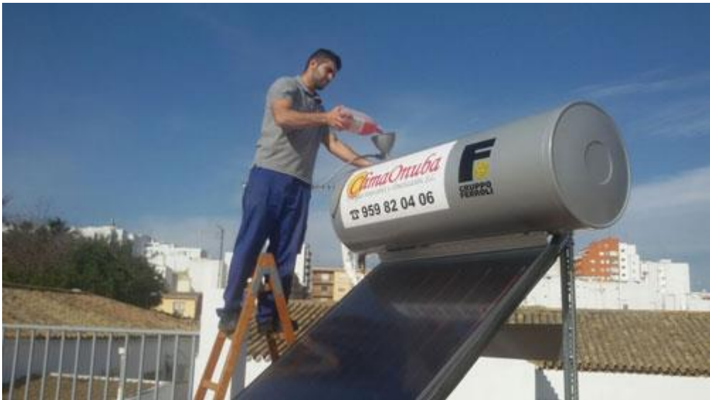
Figura 3-37. Instalación glicol.
