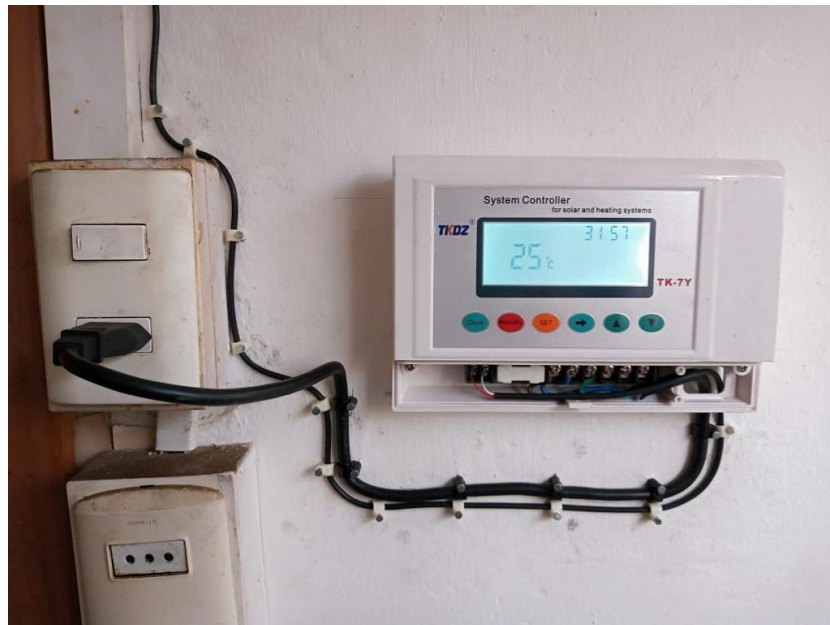
Fuente: Instalación SST Propia.
