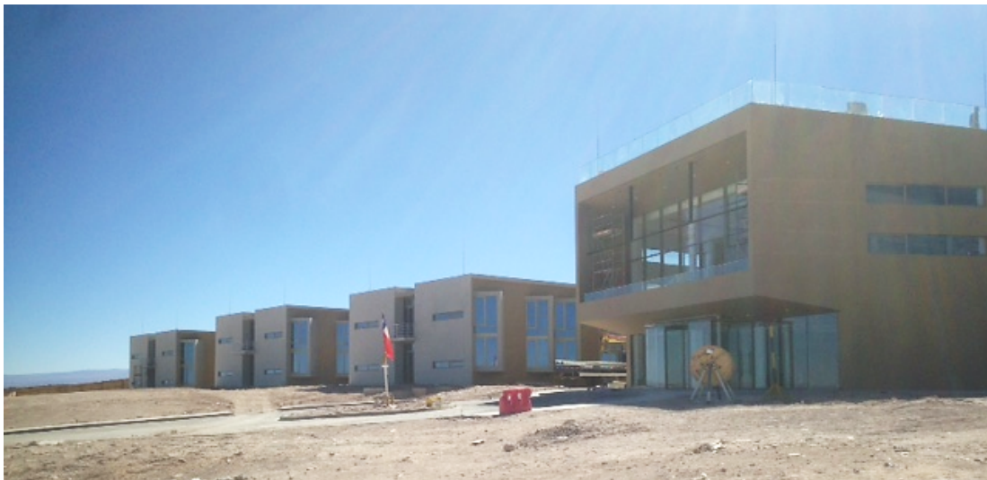
Ilustración 4: Hotel Residencia ALMA- San Pedro de Atacama. Referencia: Archivos Empresa Constructora.
